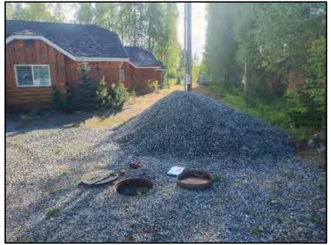
Image 2 – MH facing Latitude 62 Motel
